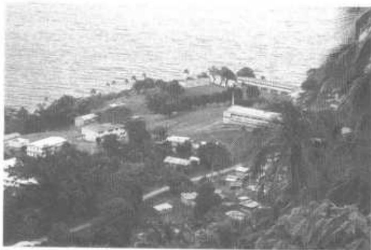
Visione panoramica della Missione di Melsisi. A destra è visibile la grande chiesa, gravemente danneggiata dal terremoto.
