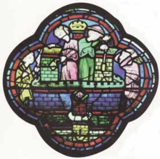
Muratori al lavoro (1210-1215) particolare di vetrata Bourges, Saint-Etienne
