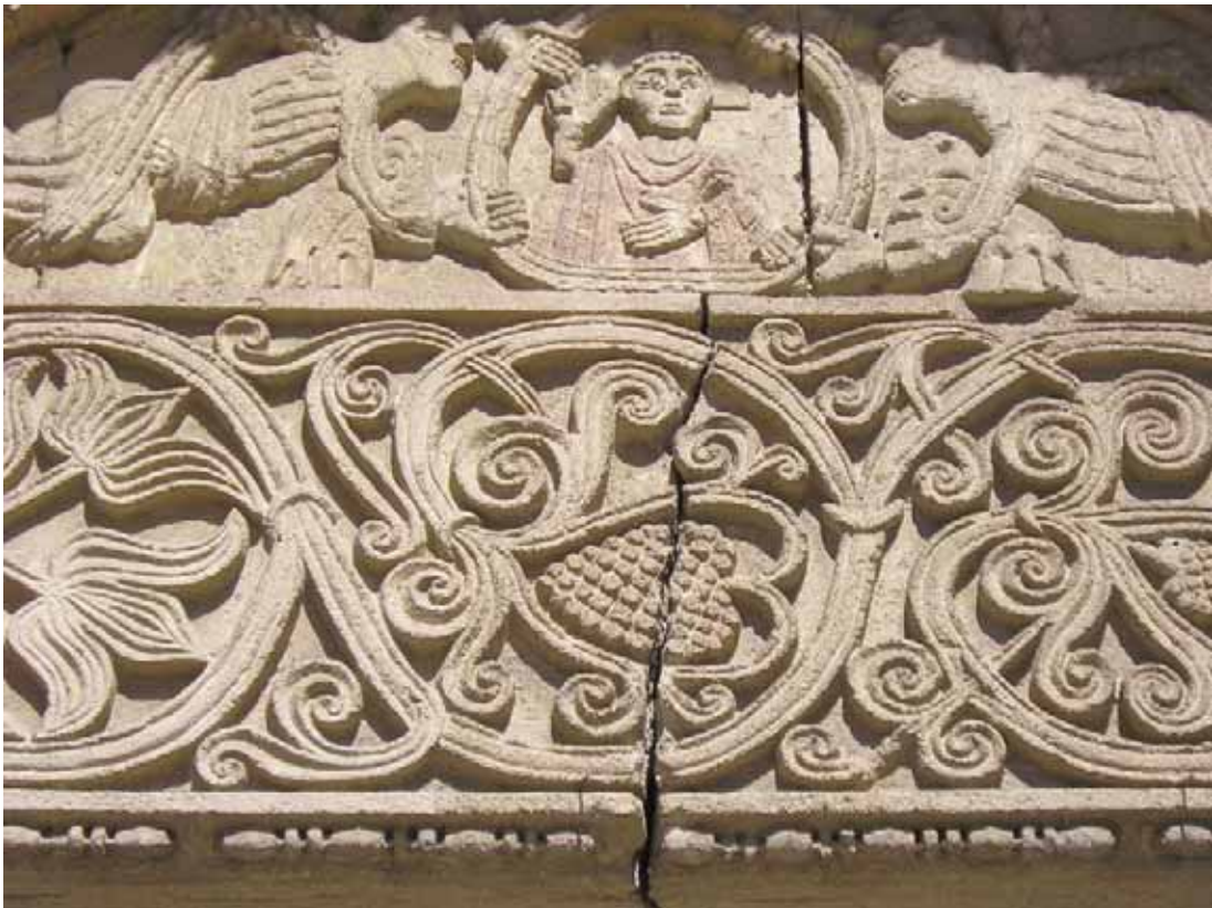
Particolari della lunetta e dell'architrave del portale
