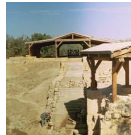
I lavori fervono sul versante israeliano del Giordano
