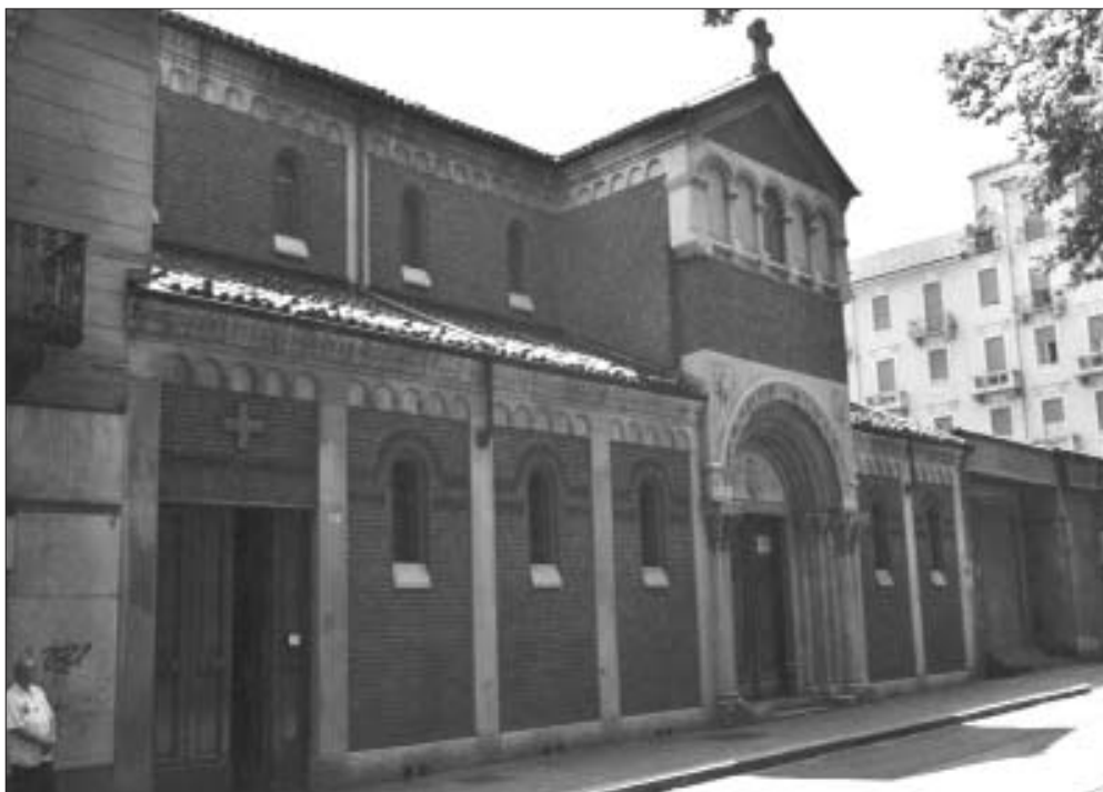
L'esterno del Santuario di Corso Francia a Torino
